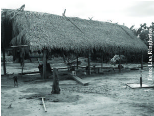
Typisches Tsimane'-Haus im Dorf (traditionell ohne Wände, nur vier Pfosten und Palmendach aus der Motacu-Pfirsichpalme).
